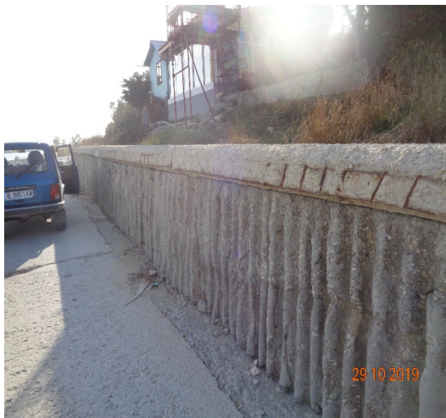
нарушения по подпорните стени и по дамбата
