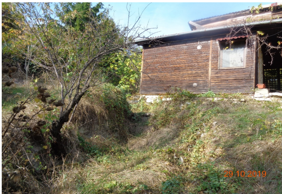
29.10.19 г. свлачищния отстъп в ПИ 30
