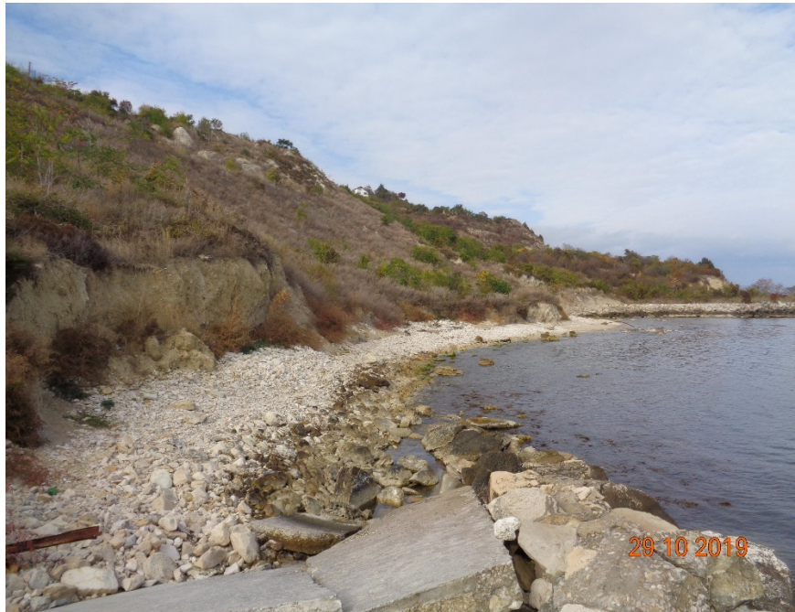
поглед от разрушения траверс към централната част на свлачището
