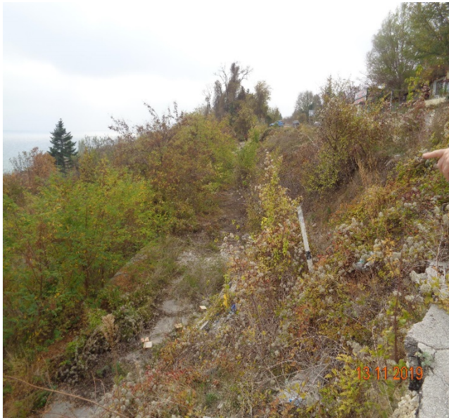
свлачищният отстъп – поглед на юг
