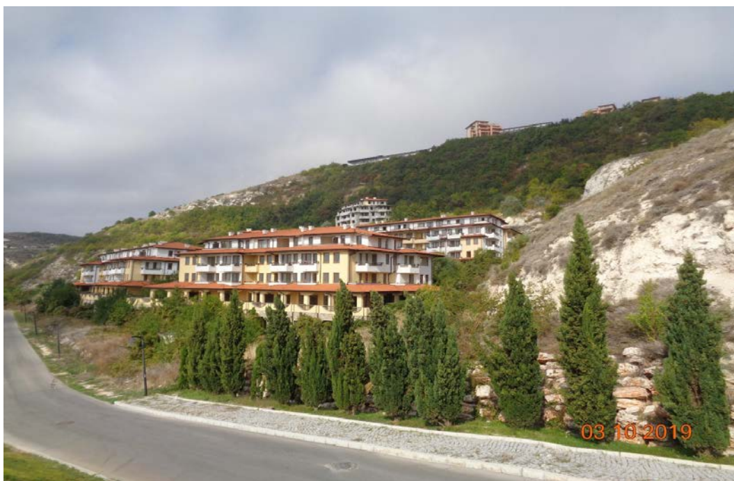
общ изглед на района на DOB 17.05009-01-03
