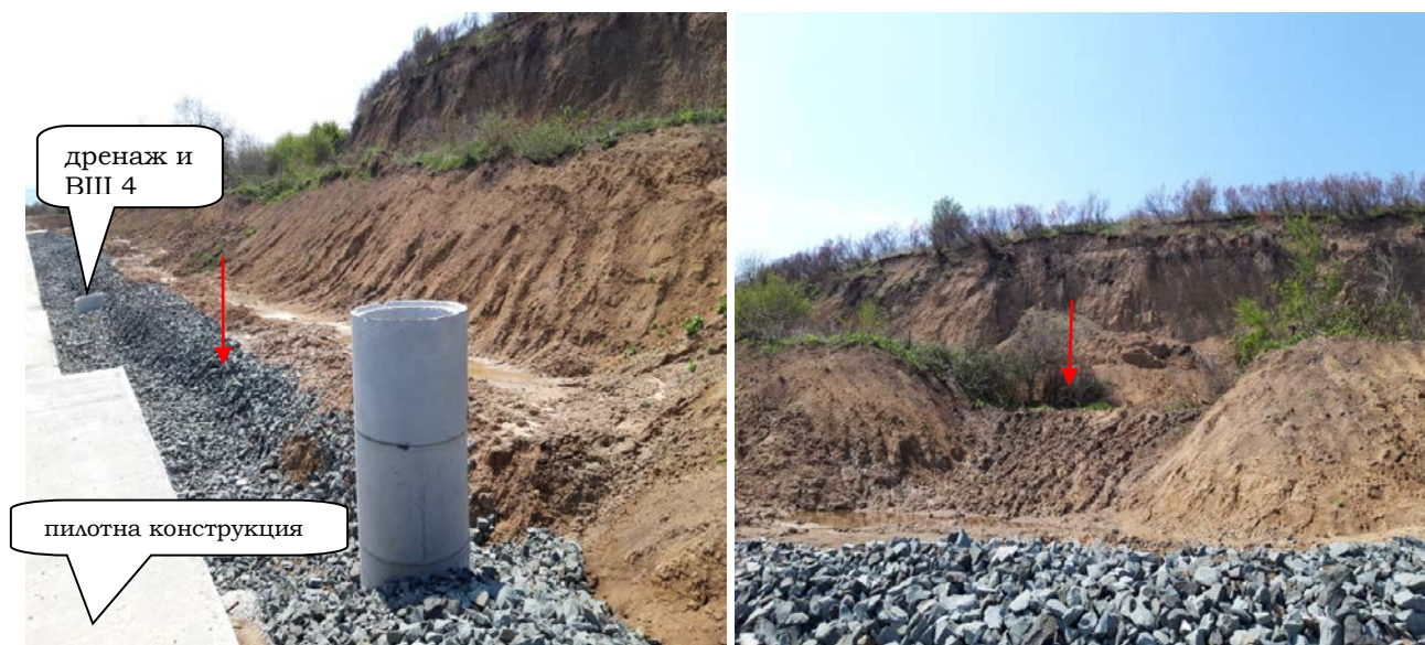
вал на изтласкване 16.04.19 г. траншея в свлачището
