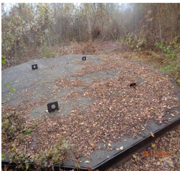
ВШ1 – липсва парапет около шахтата
