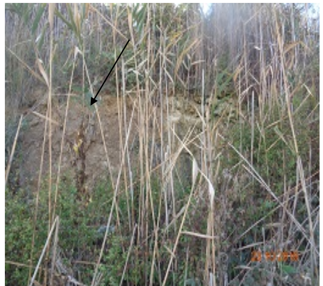
дрениране на вода в петата на откоса
