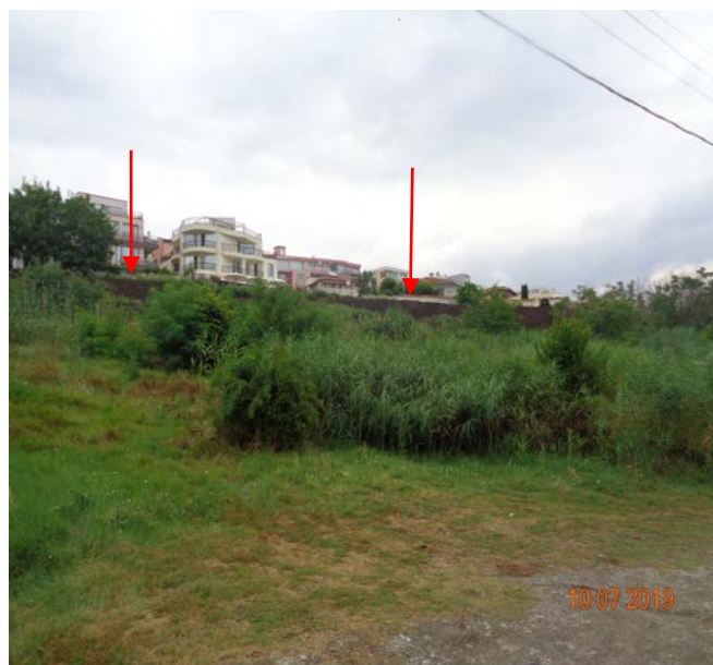
насипани земни маси в зоната на свлачищния отстъп
