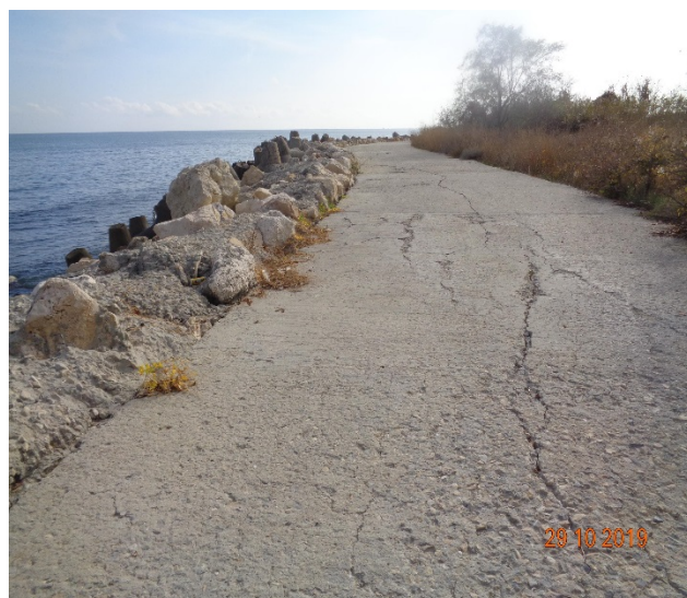
стръмния откос в северната част и пукнатини по дамбата (около ИС 223)
