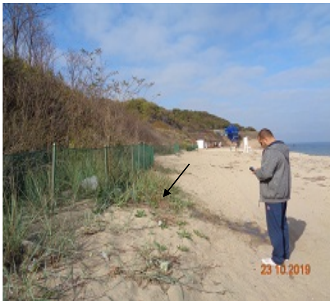
дрениране на вода в петата на откоса
