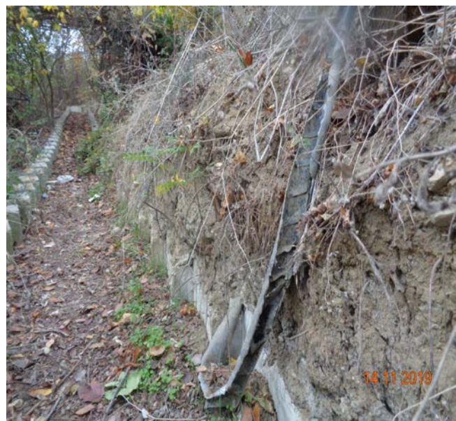
отстъп на локално свлачище пред ПАК № 2 и свлачищния вал в подножието на склона
