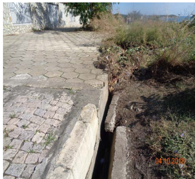
10. 07.2019 г. състояние на канавката над свлачището – 04.10.2018 г.
