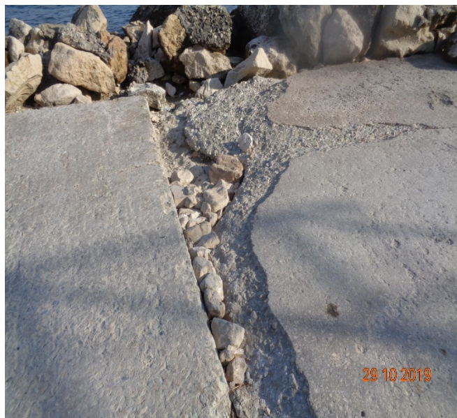
нарушения по подпорните стени и по дамбата
