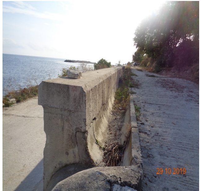
бетоновите канавки зад подпорните стени
