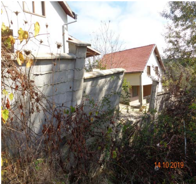
наклонена и разрушена масивна ограда 14.10.2019 г.
