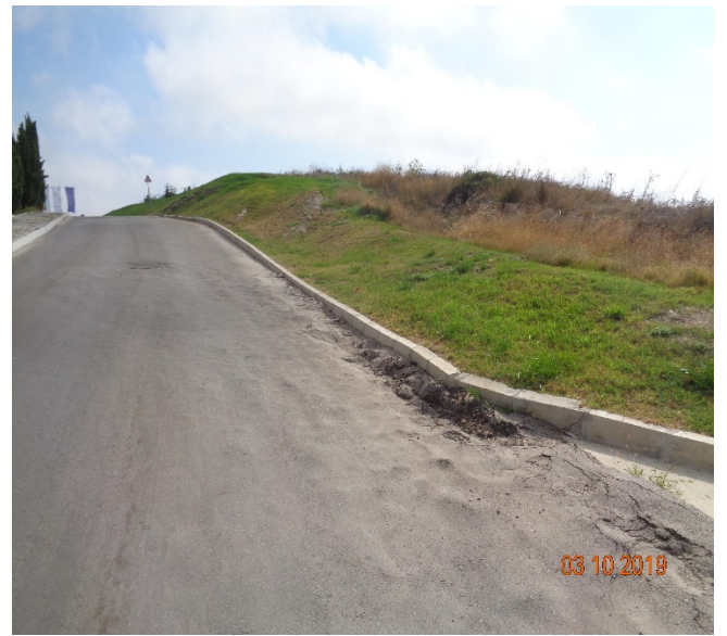
ляв борд на свлачището-поглед на запад вълнообразно нагъване и издигане на асфалта, издигането възпрепятства оттока на вода по изградения за целта бетонов улей
