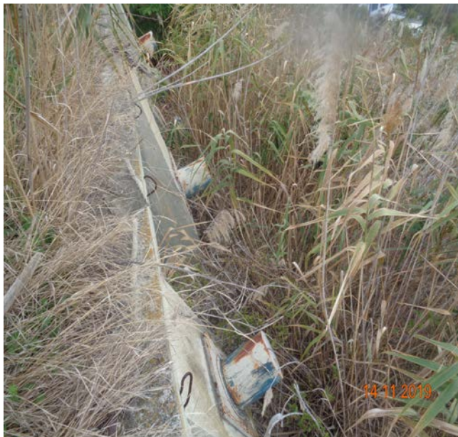
анкерна конструкция 7 и нарушение в бетона /вижда се арматурата/
