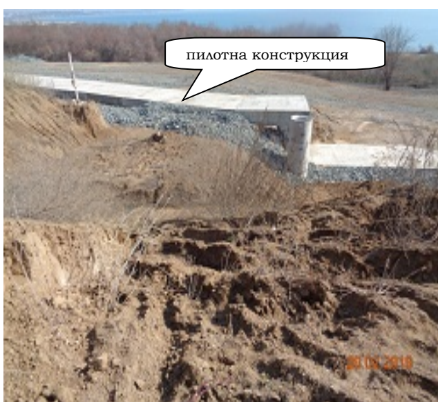
пукнатини в свлачищното тяло
