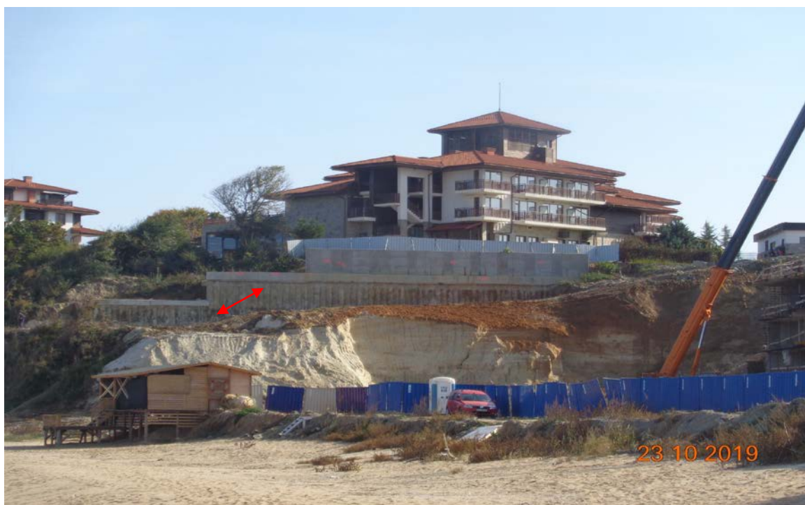
укрепителни конструкции над десния борд на свлачището
