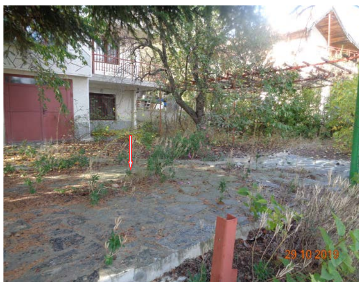
ПИ 59 подуване на плочника пред къщата
