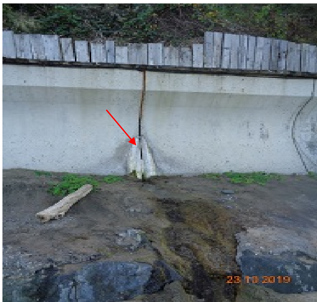
дрениране на вода с неясен произход
