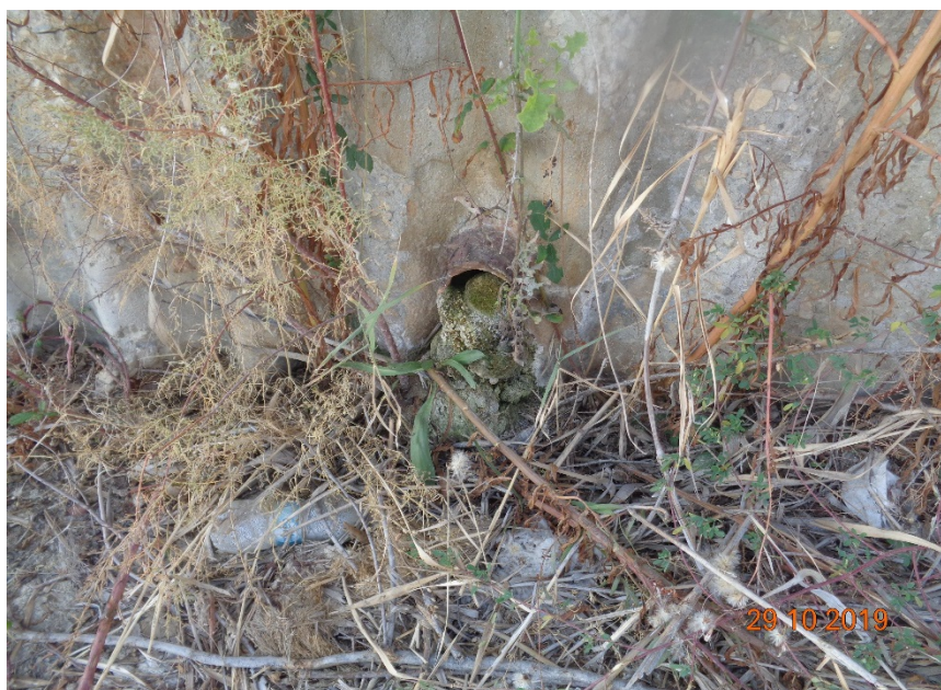
PVC тръбата е запушена от бигор
