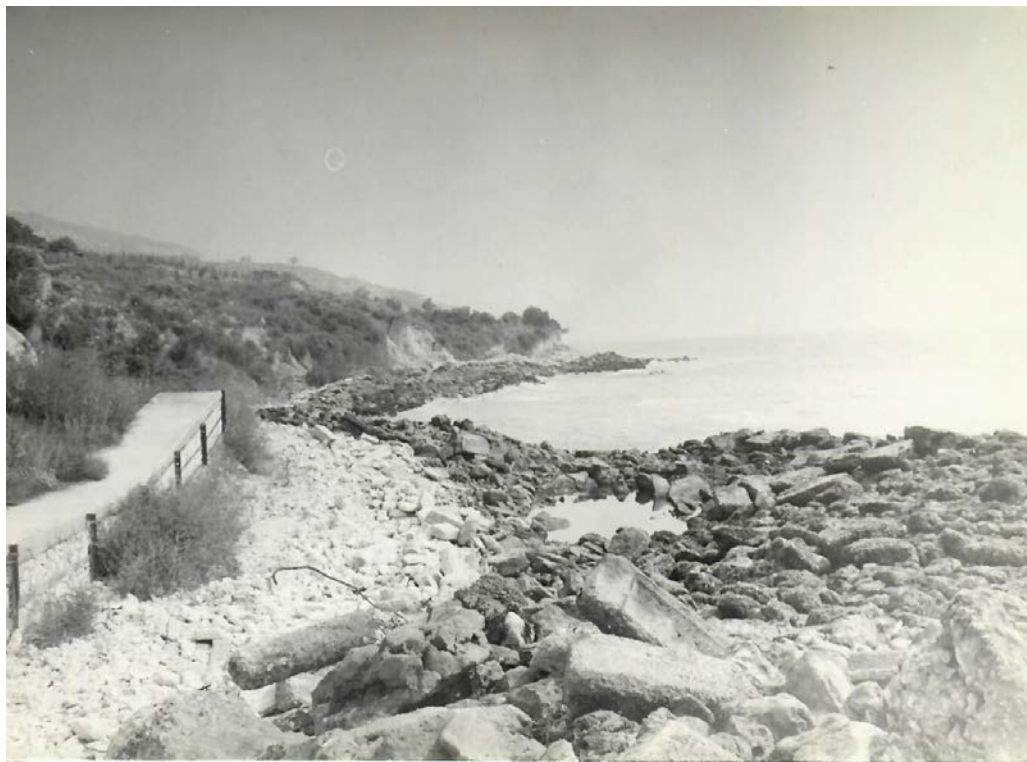
1978 г. - свлачищен вал в морето пред брегозащитната стена
