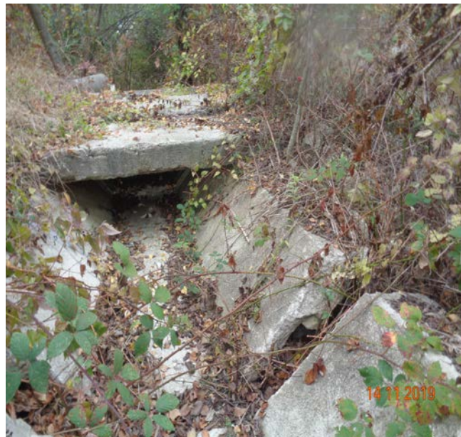
скъсване на открития канал
