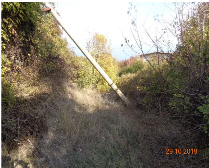
наклонен ел.стълб
