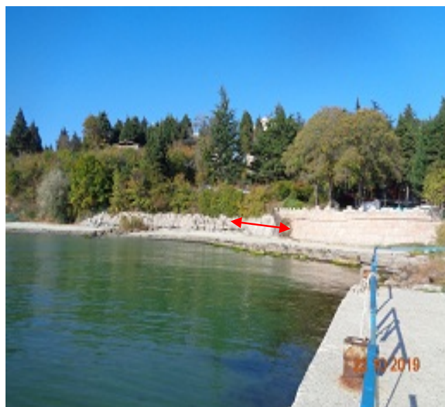
подпорна стена в западната част
