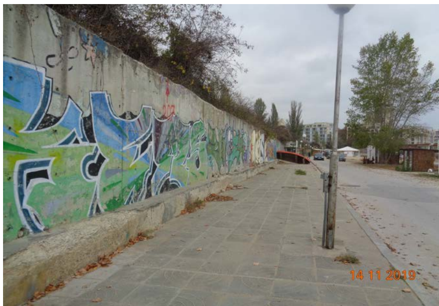
нарушения по пилотна конструкция 1
