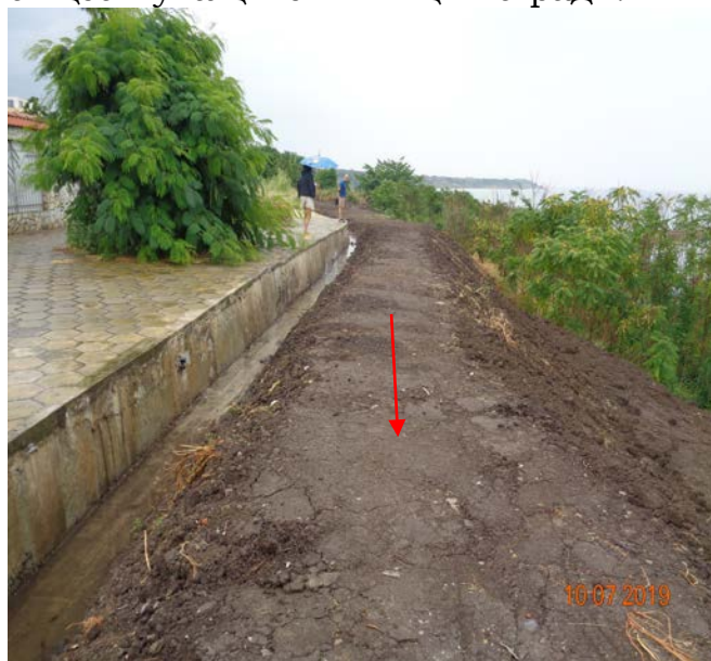
насипани земни маси в зоната на свлачищния отстъп
