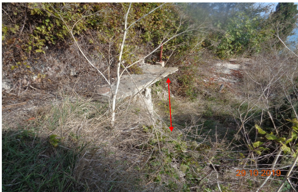
29.10.19 г. - свлачищния отстъп в ПИ 29
