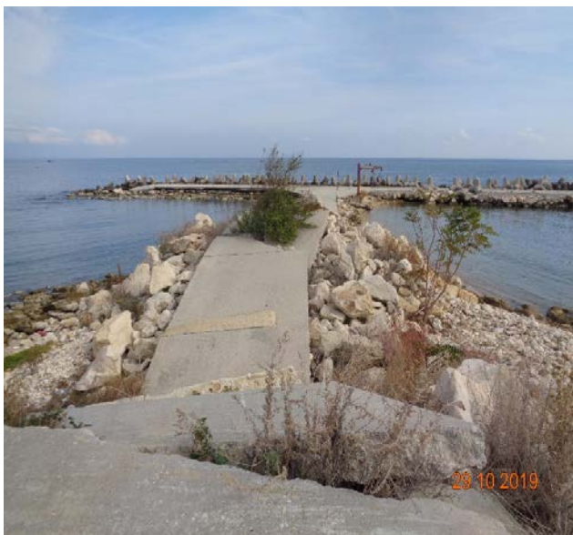
разрушения траверс
