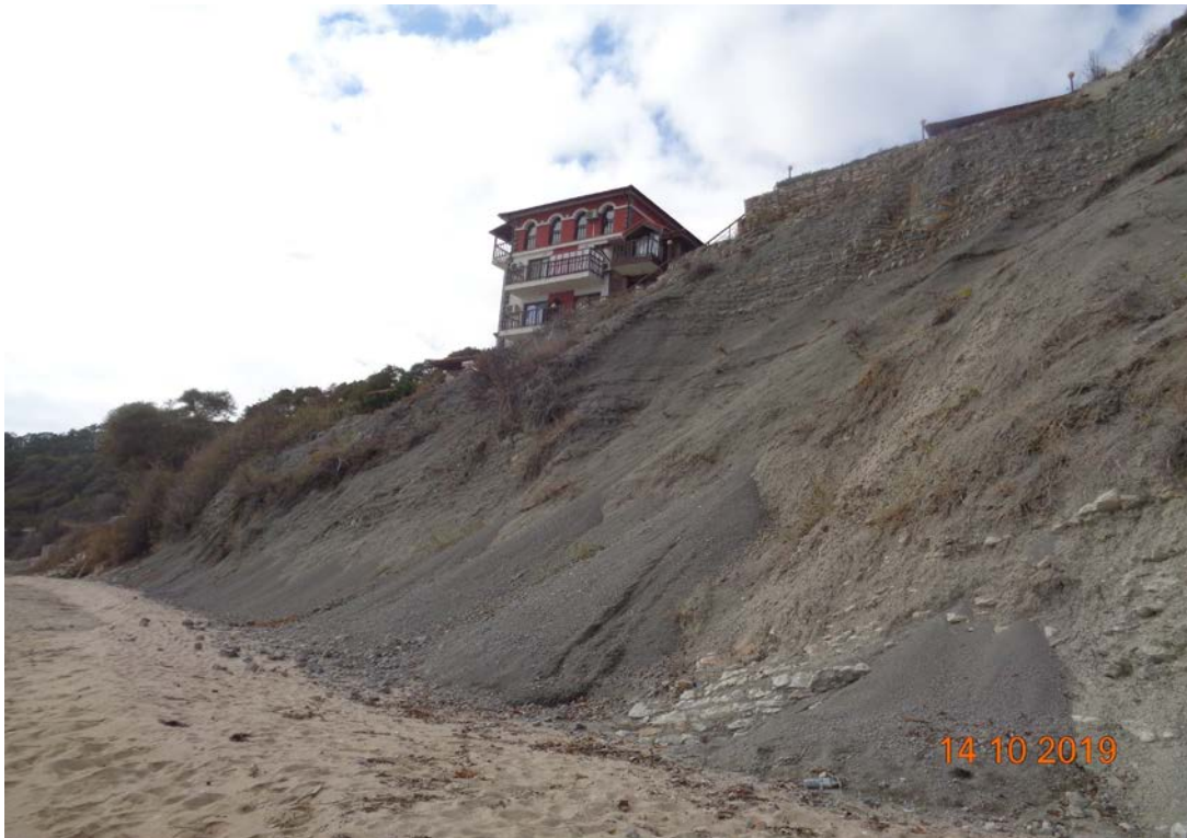
общ изглед на бреговия откос-поглед на юг
