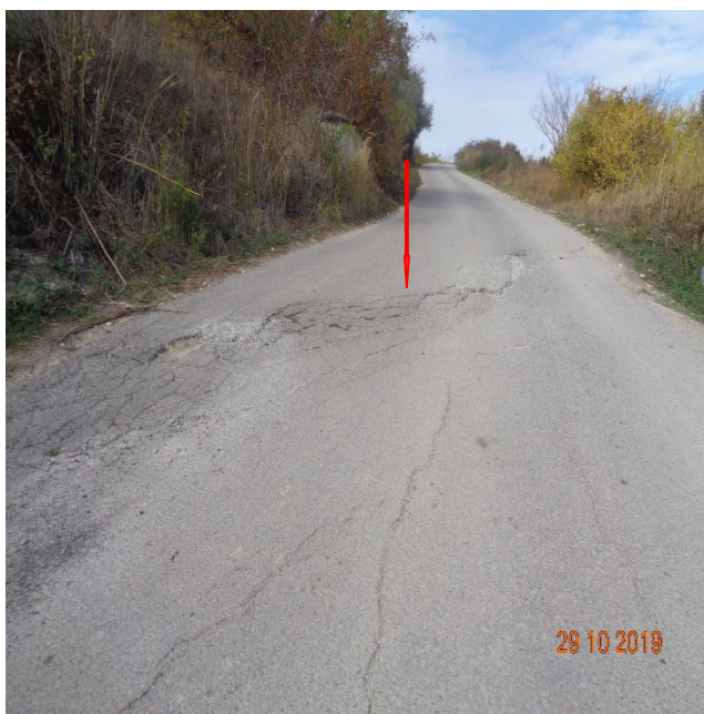
деформации по технологичния път
