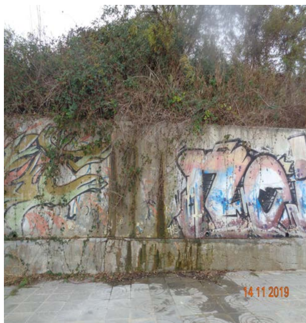
води, преливащи над ПК-1 от шахта за дренажно ребро 3
